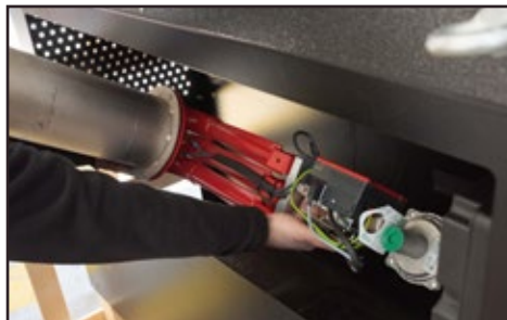
6 - Retirar el quemador del compartimento
