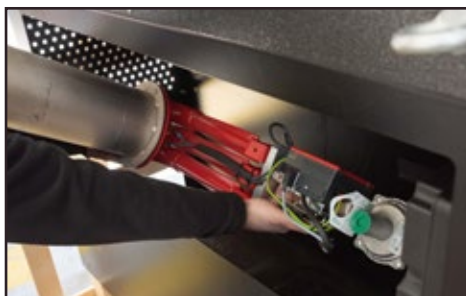
6 - Rimuovere il bruciatore dal vano Mettere il bruciatore in orizzontale per favorirne l'estrazione.
